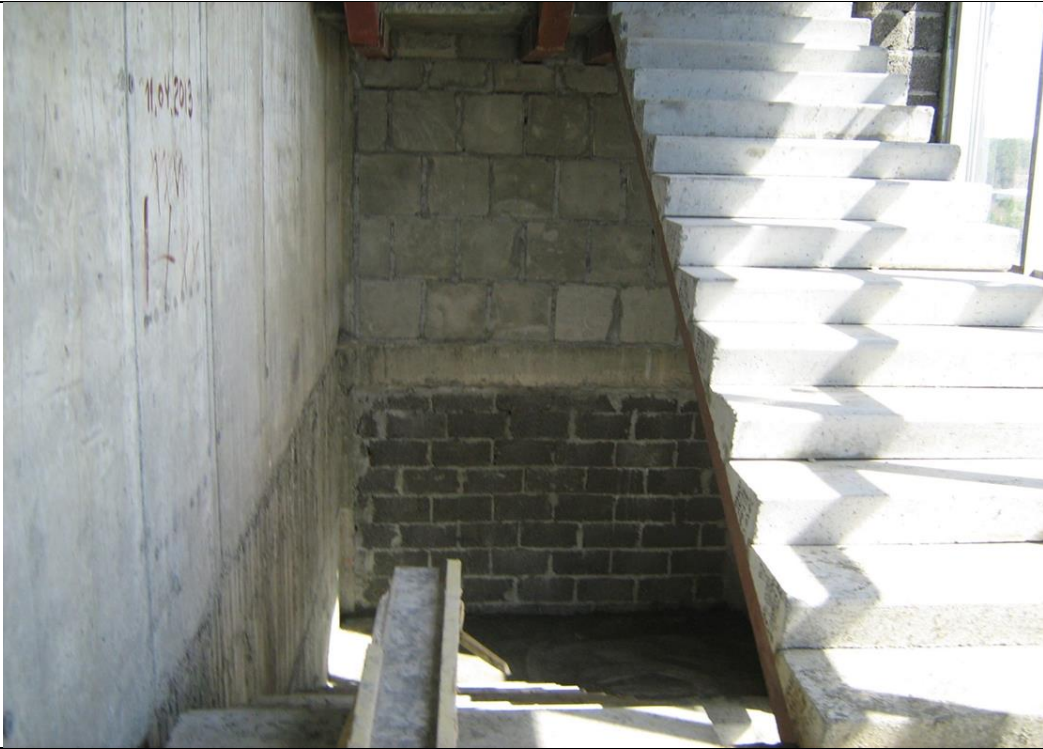
1) Смонтированный лестничный марш
