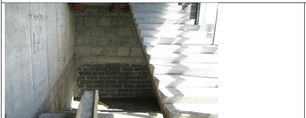
1) Смонтированный лестничный марш
